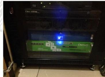
Foto 5. Equipo Central Telefónica DENWA en NAMIRA S.A.
