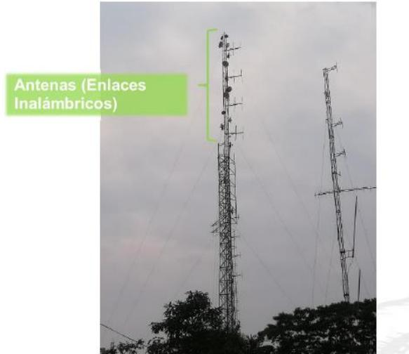
**Imagen 2.** Torreo soportada con varias antenas para enlaces inalámbricos, instalada en el Nodo "Cerro Lumbaqui", del cerro Lumbaqui, del cantón Gonzalo Pizarro de la provincia de Sucumbíos.
