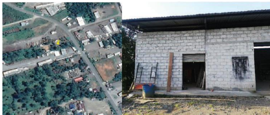
Imagen 4.2. Head End del sistema de audio y video por suscripción “ASPITV”, ubicado en el Kilómetro 5 de la vía Coca – Lago Agrio, junto a la compañía VARCO SP, de la ciudad de El Coca, provincia de Orellana. (Coordenadas: Latitud: 0°25'22.96"S - Longitud: 76°59'36.33"O).
