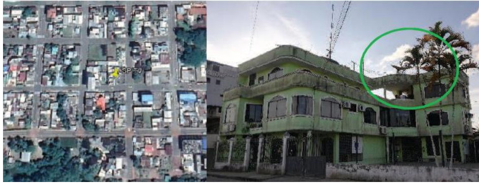
Imagen 4.4. Antiguo Head End del sistema de audio y video por suscripción denominado “ASPITV”, ubicado en las calles Eloy Alfaro 867 y 12 de Febrero de la ciudad de Puerto Francisco de Orellana, provincia de Orellana. (Coordenadas: Latitud: 0°28'26.38"S - Longitud: 76°59'11.98"O).
