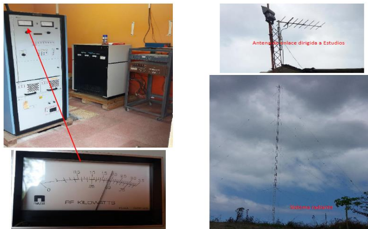
Gráfico 4. Equipos encontrados en la caseta de RADIO UNION AM (1490 KHz) en el Loma San Martin
